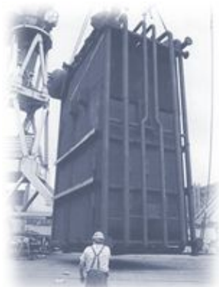
Abb. 16: Montage eines ERK
